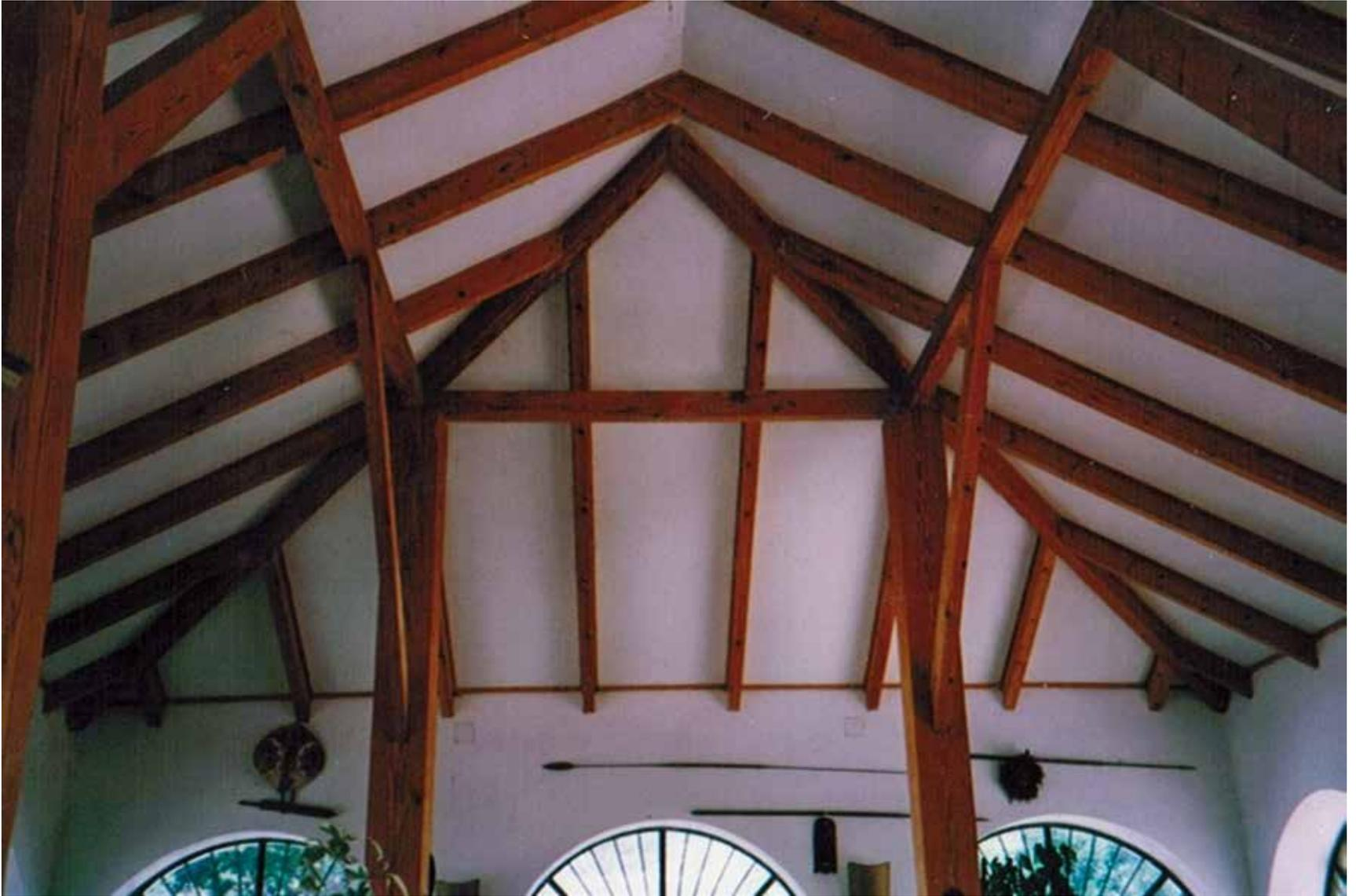
Vista de la estructura de vigas del interior construida con madera de distintas variedades de pino.
