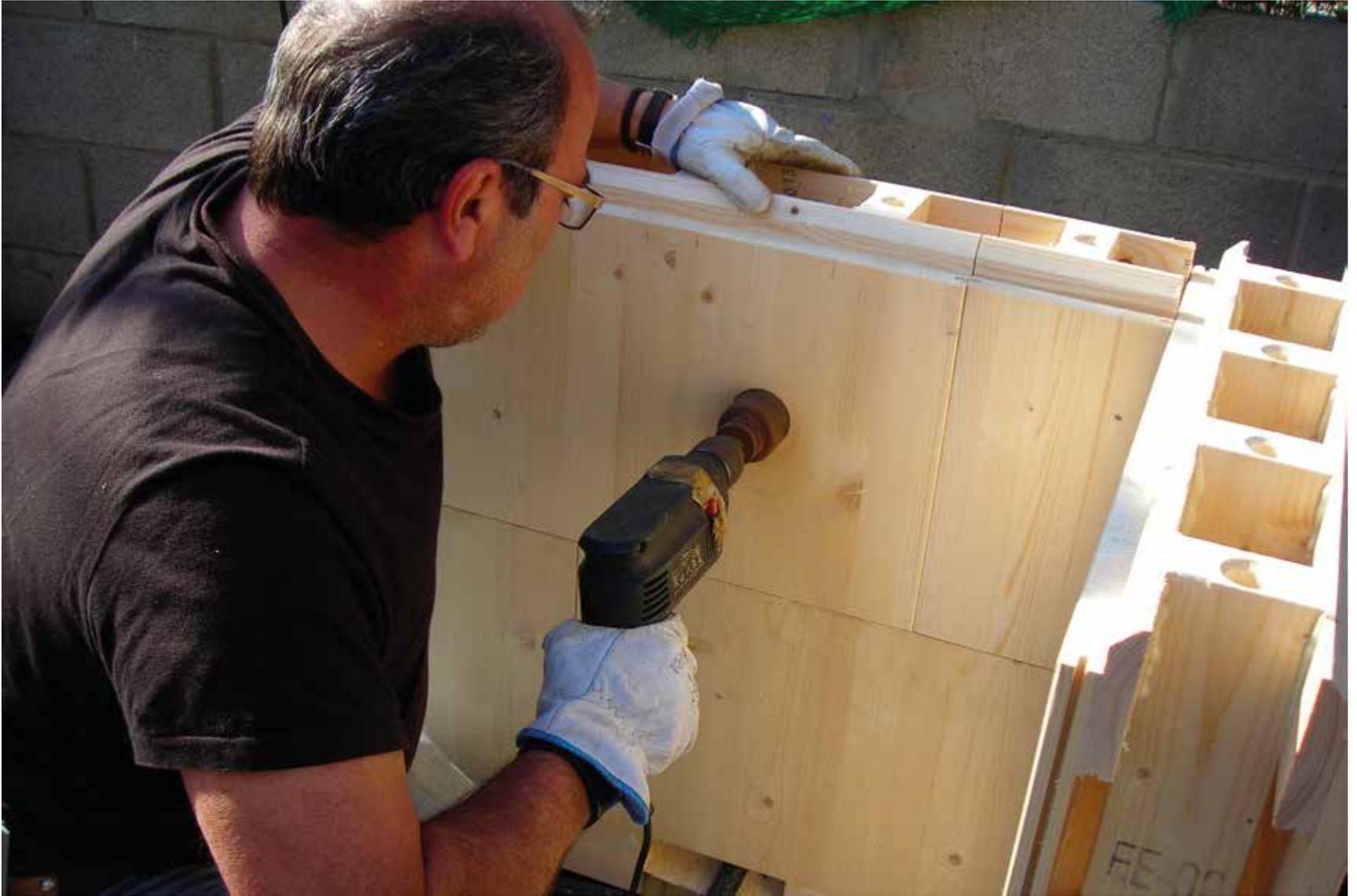
Preparación de las paredes para la instalación eléctrica.
