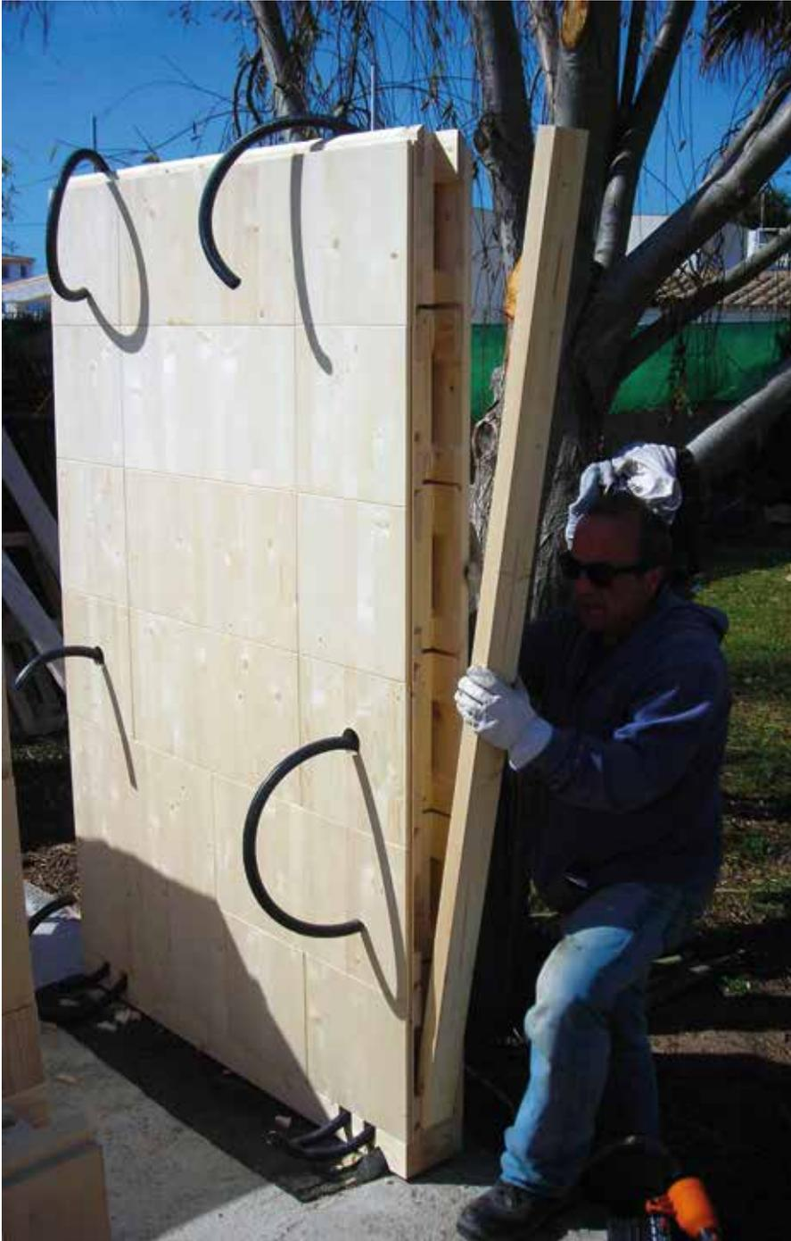
Refuerzo de las paredes y construcción simultánea de marcos frontales para ventanas y puertas.
