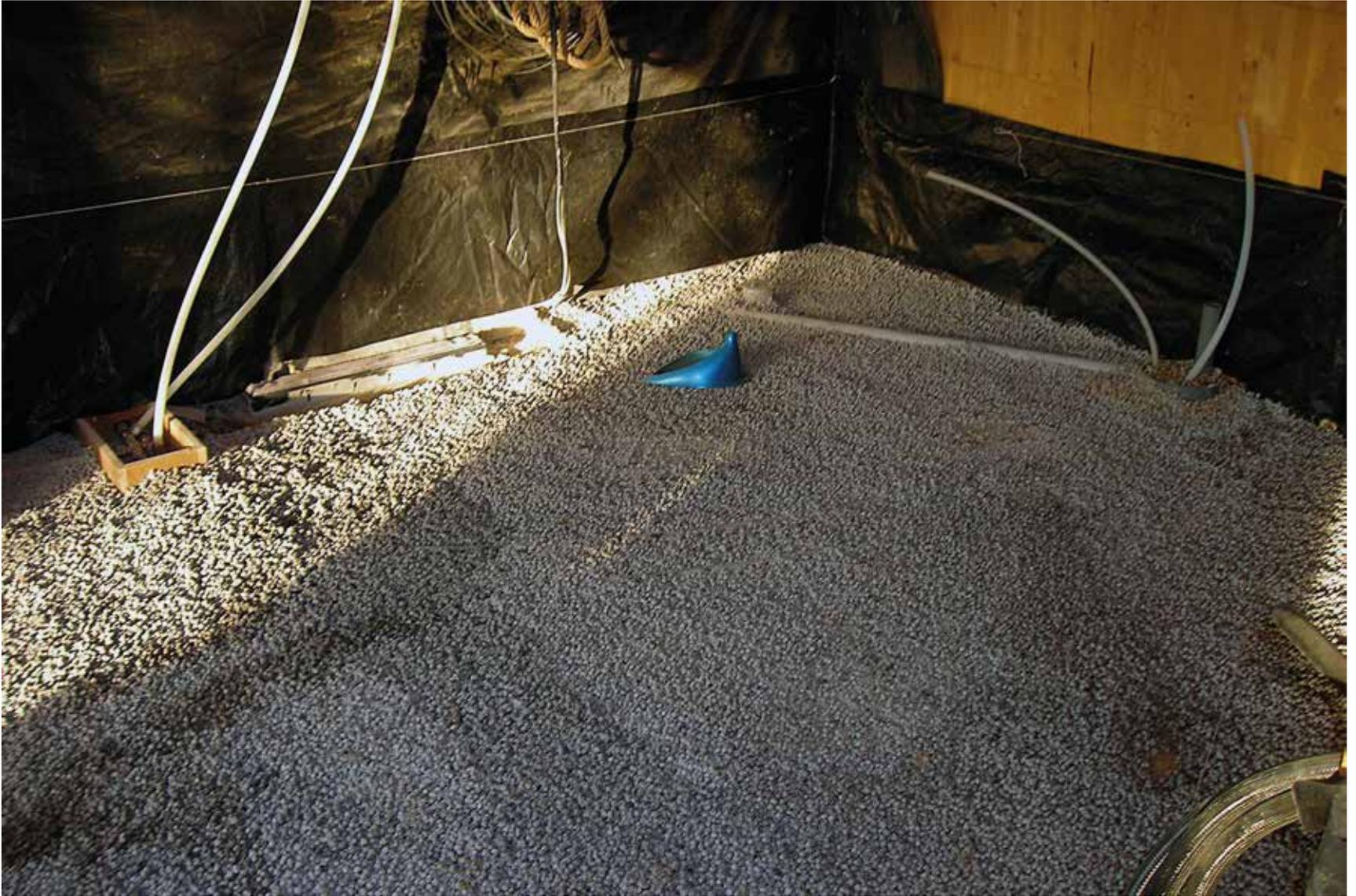
Suelo con Arlita (arcilla expandida) y montaje de infraestructura (desagües, agua y electricidad).
