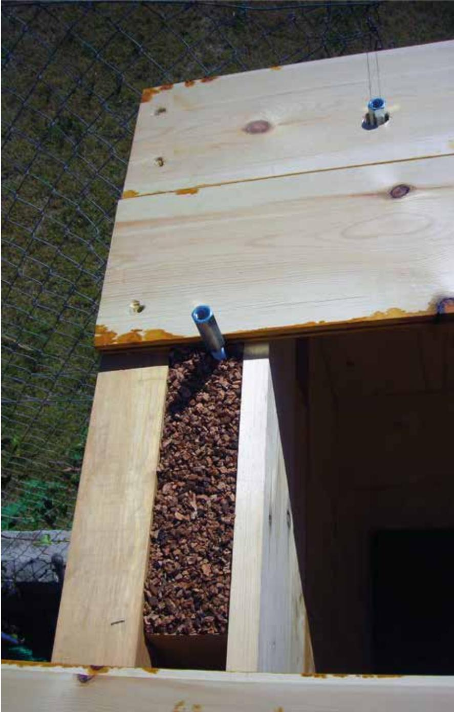
Befestigung der Wand am Fundament mit Gewindestangen und Befüllung mit Granulatkork.
