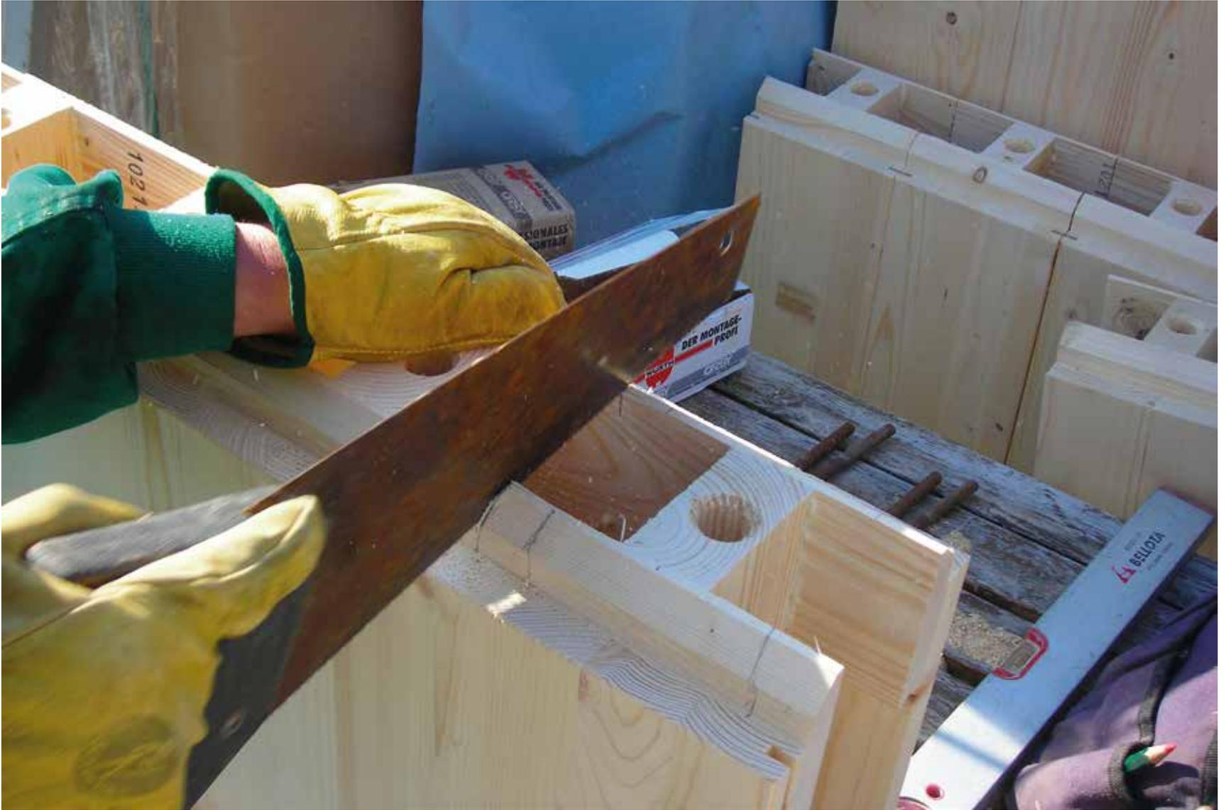
Vorbereitung der Module für die Montage in Ecken.
